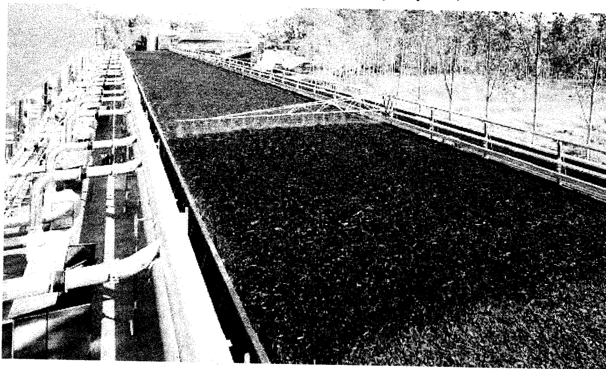
Biofiltr działający w zakładzie unieszkodliwiania odpadów komunalnych (1.100 m 2 Lacchiarella MI)
