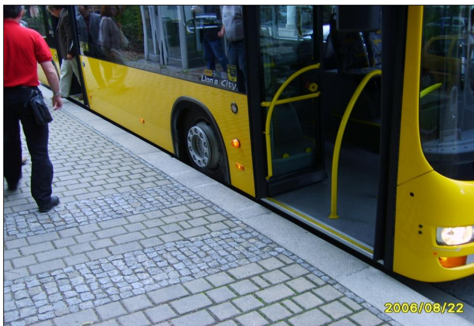
Fotografia 6: Peron przystankowy dostosowany do wysokości podłogi w autobusie niskopodłogowym.
