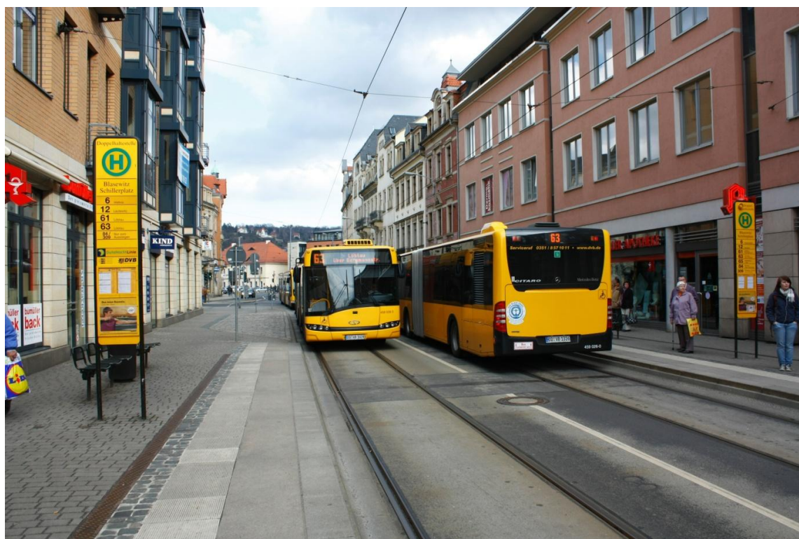
Fotografia 3: Przystanki autobusowe z podwyższonymi peronami- Drezno, Schillerplatz.
