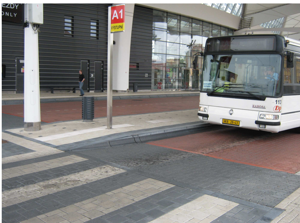
Fot. 5.24. Podwyższony peron przystankowy wraz z wyprofilowanym krawężnikiem – dworzec autobusowej komunikacji regionalnej w Hradec Králové (Czechy). Warto zwrócić na idealne połączenie przejścia pieszego z wejściem na przystanek.
