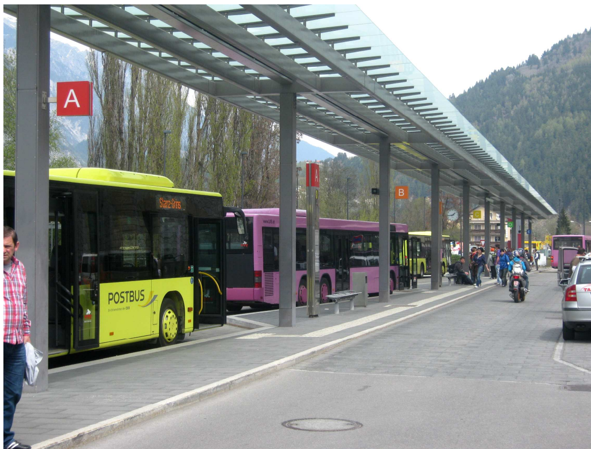
Fot. 5. 6. Stacja Landeck – Zams.
