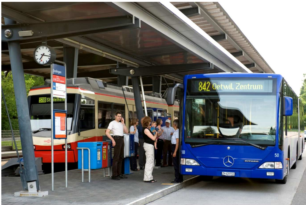
Fot. 5.8. Stacja końcowa S-Bahn w Esslingen (koło Zurichu).
