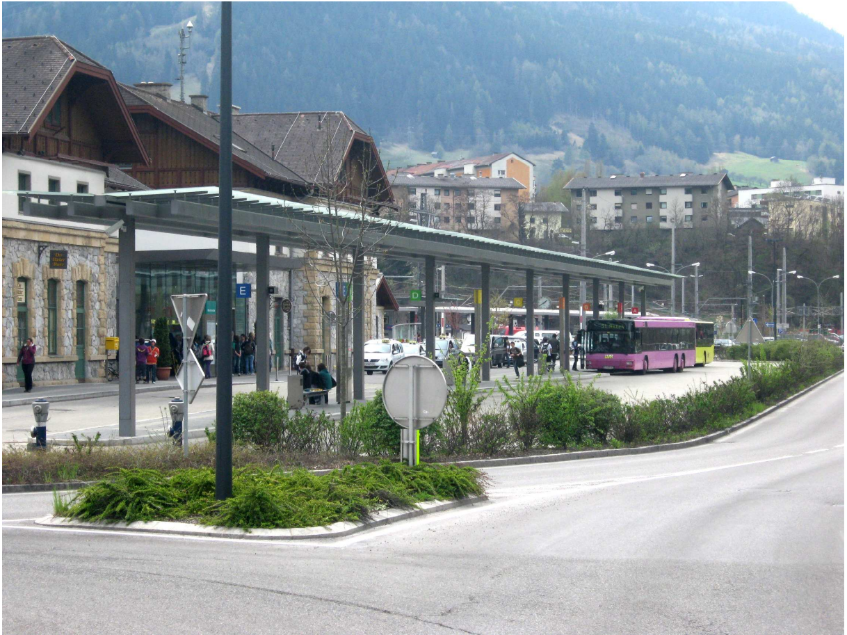
Fot. 5.4. Stacja Landeck – Zams.
