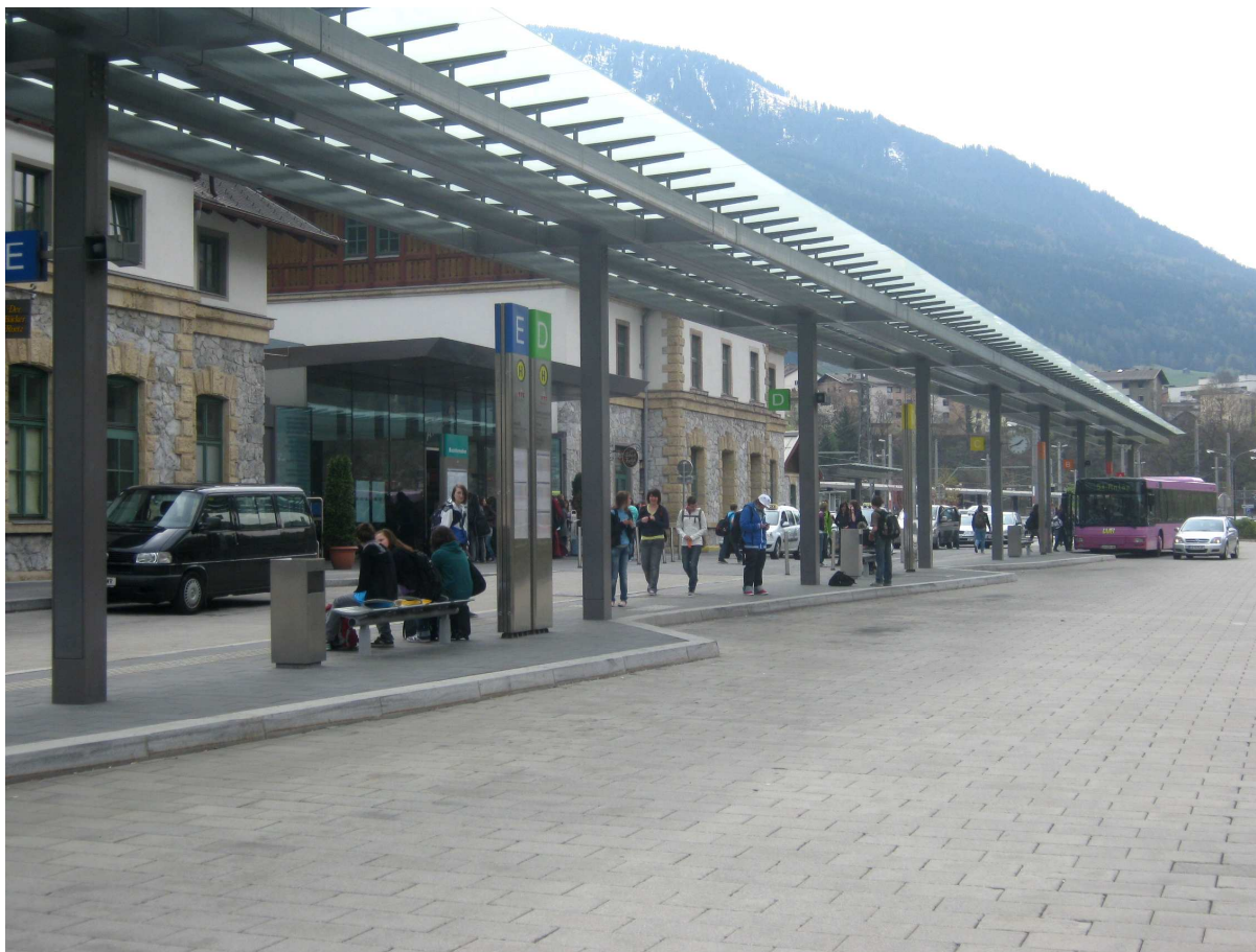
Fot. 5.5. Stacja Landeck – Zams.
