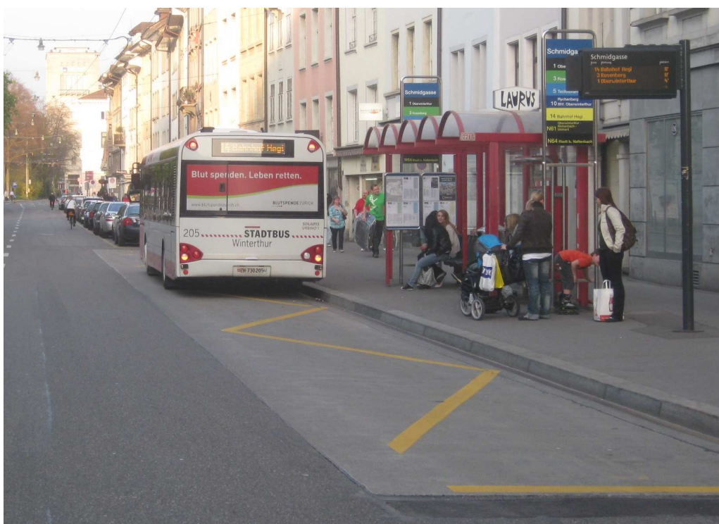
Fot. 5.19. Przystanek komunikacji miejskiej w centrum Winterthur (Szwajcaria) – bez zatoki przystankowej.
