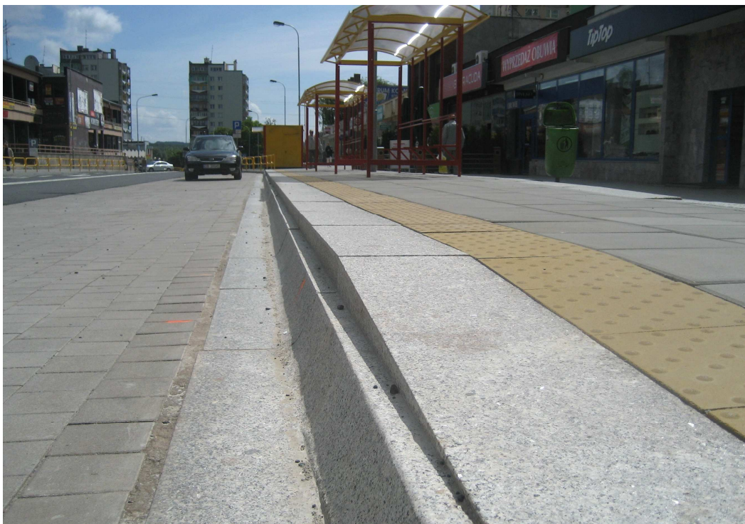
Fot. 5.25. Podwyższony peron przystanku autobusowego wraz z antypoślizgowym zabezpieczeniem krawędzi – Wałbrzych (Polska).
