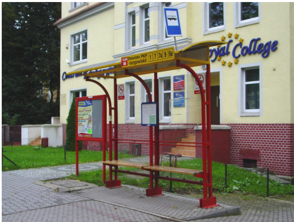
Fot. 5.11. Przystanek komunikacji miejskiej „Dworzec PKP – targowisko” w Lubinie (Polska) – konstrukcja bez ścian bocznych.
