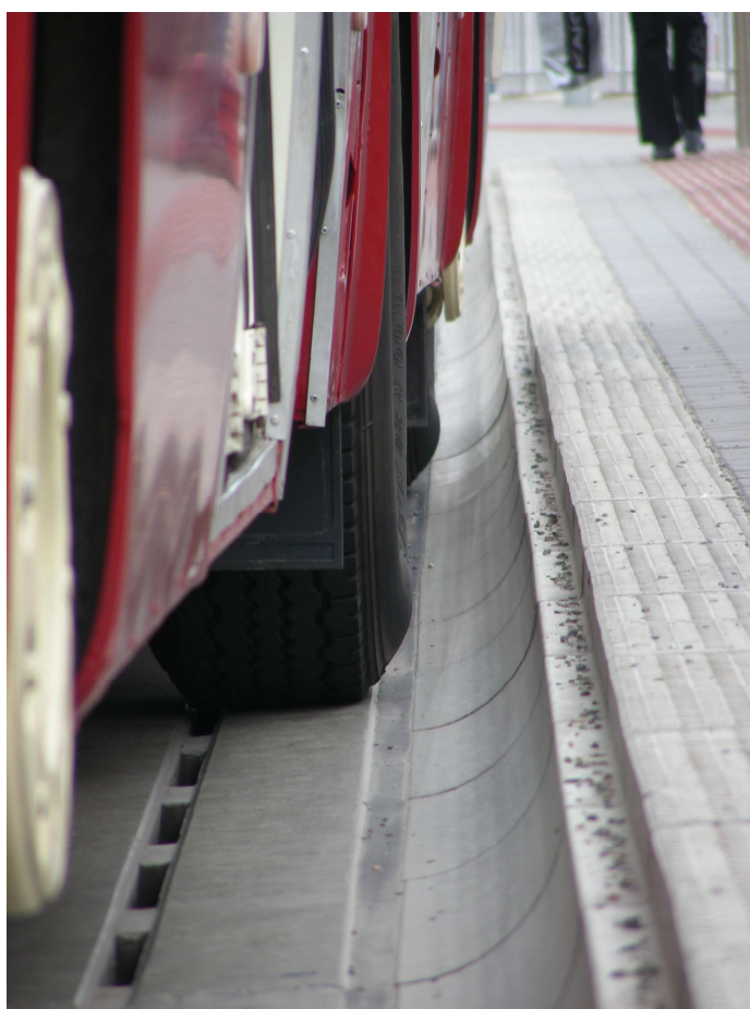
Fot. 5.26. Praktyczne wykorzystanie innowacyjnej krawędzi peronowej – Brno (Czechy).
