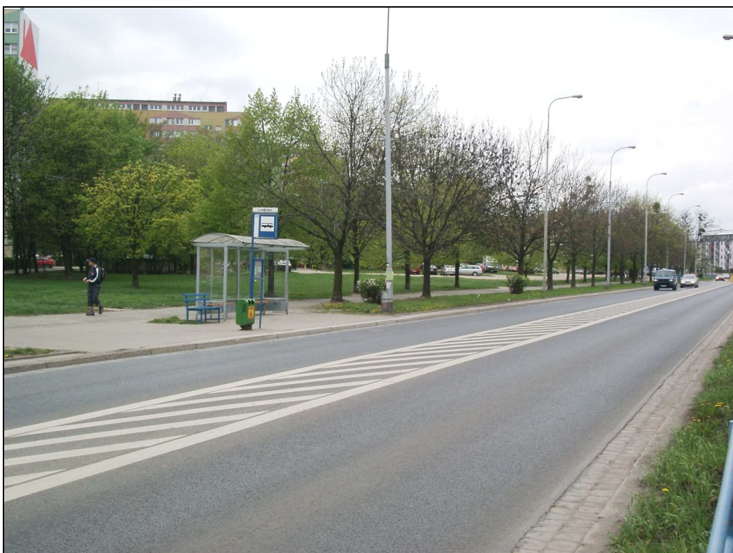
Fot. 5.20. Przystanek „Kamienna” we Wrocławiu (Polska) – przykład realizacji „bezpiecznego przystanku” z azyłem pośrodku jezdni.
