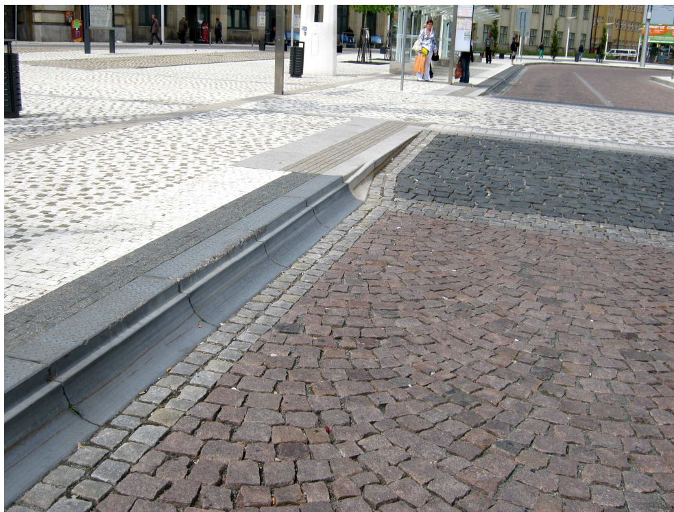
Fot. 5.23. Specjalny krawężnik przystankowy zastosowane w zintegrowanym węzle przesiadkowym przed głównym dworcem kolejowym w Hradec Králové (Czechy).
