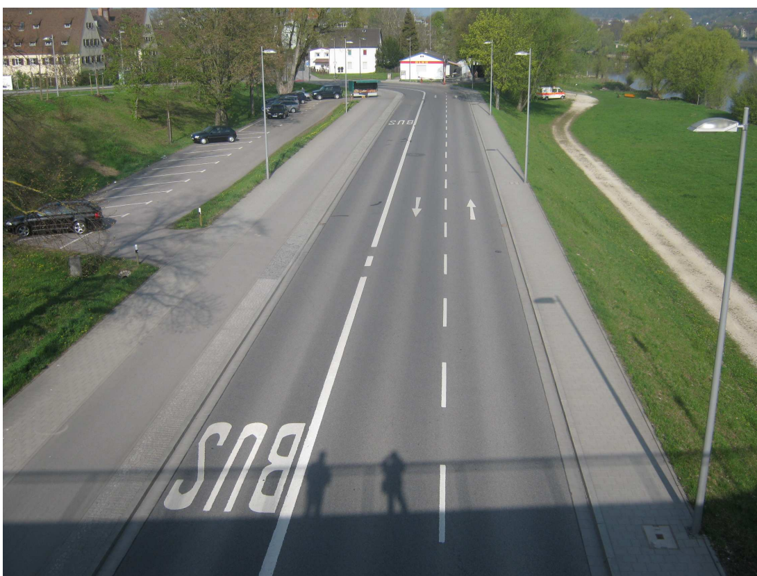
Fot. 5.31. Przykład wydzielonego pasa przeznaczony do ruchu autobusowego (Regensburg, Niemcy)
