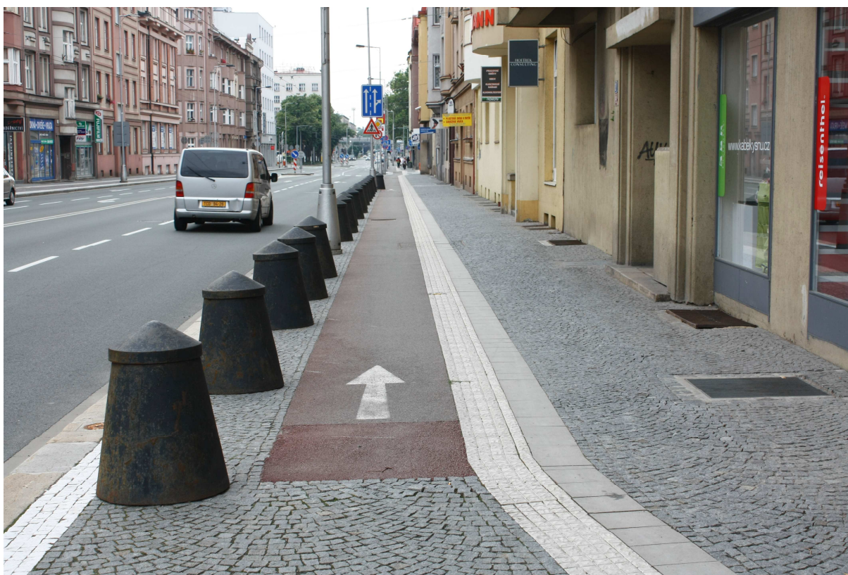
Fot. 4.1. Jednokierunkowa droga dla rowerów o nawierzchni w barwie czerwonej, równoległa do chodnika (Hradec Kralove, Czechy).
