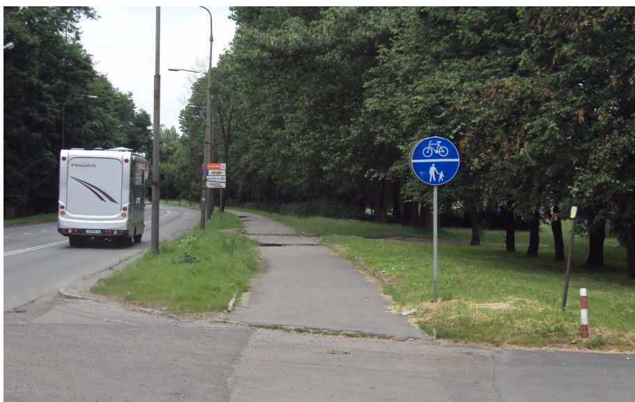
Fot. 4.2. Przykład ciągu pieszo – rowerowego o nawierzchni bitumicznej (Opole, Polska).
