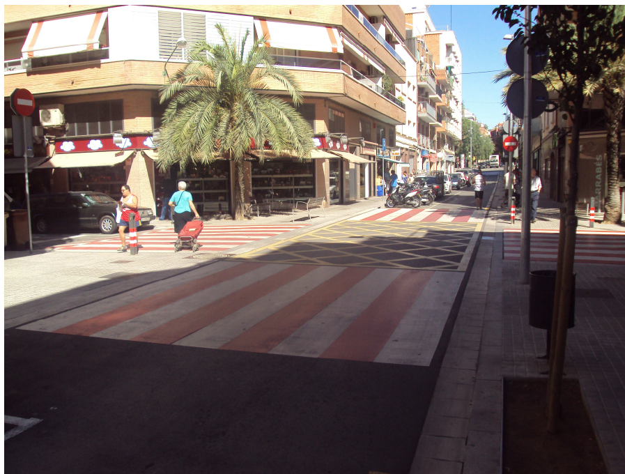
Fot. 4.13. Wyniesione skrzyżowanie w strefie „tempo 30”. Podniesienie poziomu skrzyżowania skutecznie obniża prędkość, z jaką poruszają się samochody osobowe. Co więcej, przejścia dla pieszych są na równym poziomie w stosunku do chodników. (Barcelona, Hiszpania).
