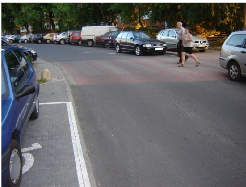
Fot. 4.14. Wyniesione przejście dla pieszych (Lubin, Polska).
