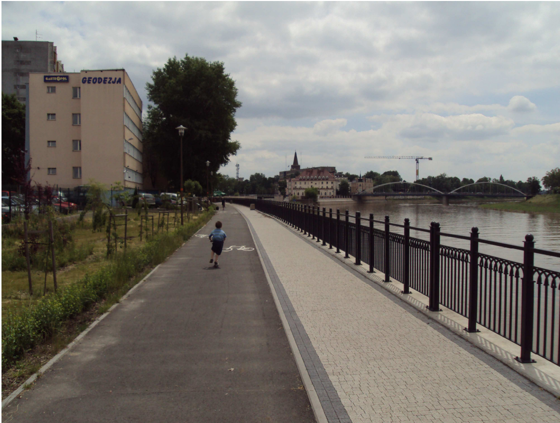
Fot. 3.1. Ciąg pieszo-rowerowy jako nadodrzański pasaż
