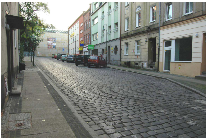
Fot. 2.3. Ul. Krawiecka, widok od Staromiejskiej w kierunku Muzealnej, po prawej stronie szeroka zatoka na 15 samochodów.
